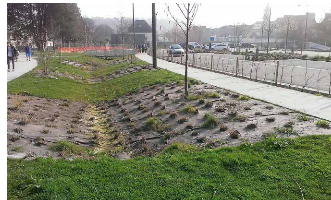
Noue en zone inondable à Quimper (29)
